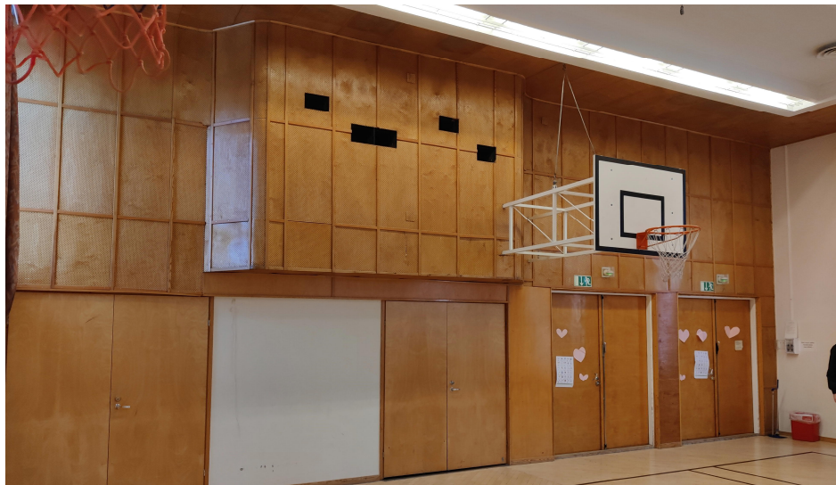
Kuva 3. Liikunta- ja juhlasalin koivuvanerpintainen seinä. Kuvassa myös alkuperäisen projektorihuoneen aukotusta.
